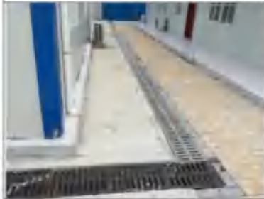
临时排水沟 (2021年1月)
