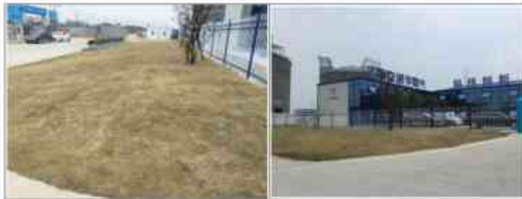
施工区生活区临时绿化 (2020年12月)
