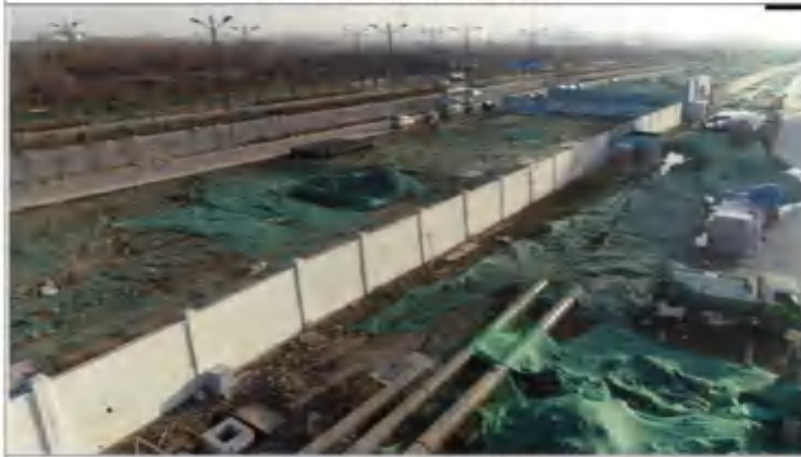
进场道路区现状（2020年10月）
