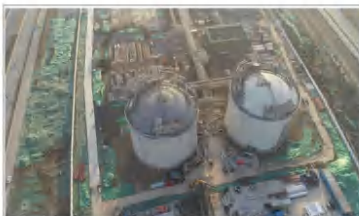
主体施工区施工现状 (2020年11月)
