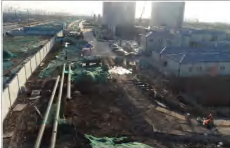
主体施工区施工现状（2020年10月）
