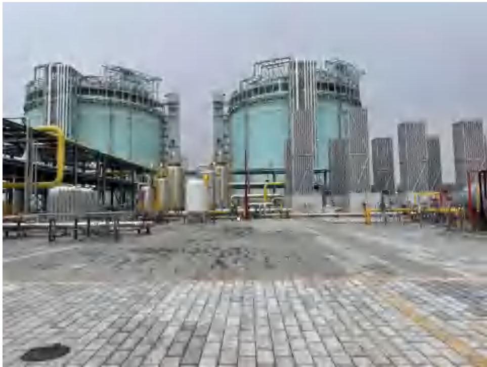
储罐及装卸区现状（2021年7月）
