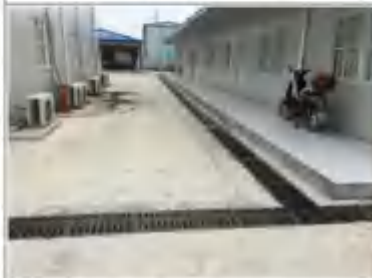
临时排水沟 (2021年6月)
