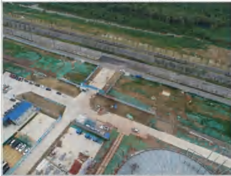
进场道路区现状 (2020年9月)
