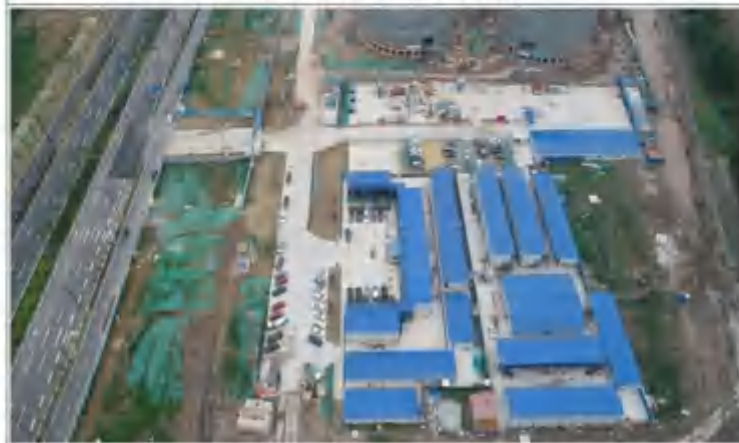
施工生产生活区、进场道路区现状 (2020年8月)
