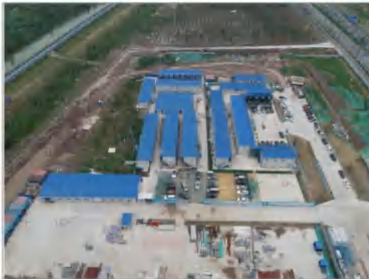
施工生产生活区、临时堆土区现状 (2020年9月)
