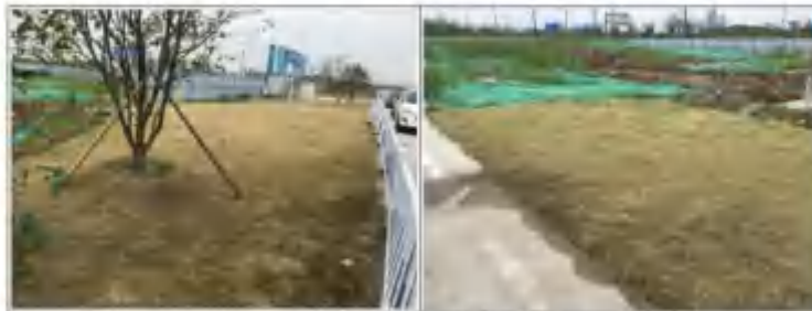
施工生产生活区临时绿化(2020年8月)
