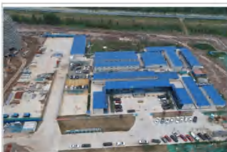
施工生产生活区现状 (2020年7月)
