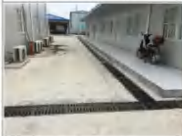
临时排水沟 (2021年3月)
