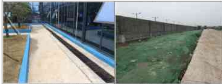
临时排水沟 (2020年10月)
