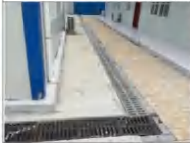
临时排水沟 (2021年4月)
