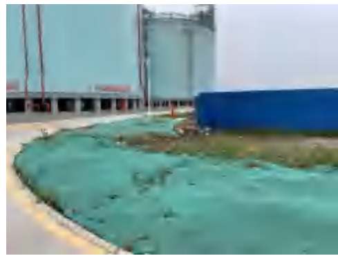
临时苫盖 (2021年8月)
